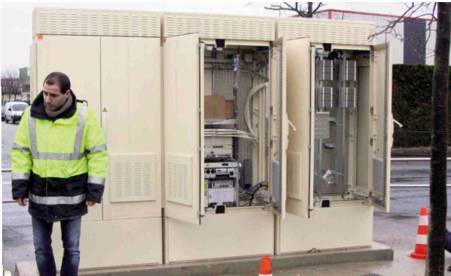
Un NRA-MED du type de celui qui sera implanté rue du ravin d'embarre
